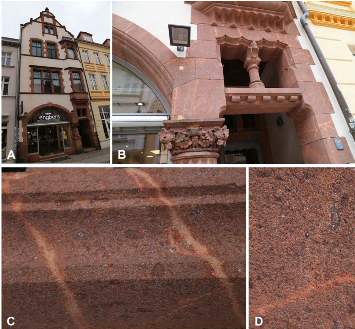
Abb. 12: A-B Die auffällig gestaltete Fassade eines Wohn- und Geschäftshauses in der Langen Straße zwischen dem Greifswalder Markt und dem Fischmarkt besteht aus Natursteinen des Rochlitzer Porphyrtuffs. Dieser ist an seinem rötlichen Farbspiel und den gelblichen Adern oder Schlieren leicht zu erkennen. C-D Detailaufnahmen des Gesteins zeigen, dass es sich um einen Ignimbrit handelt, der durch gelängte Lava- und Schlackefetzen (Fiamme) gekennzeichnet ist. Er entstand bei einer der größten weltweit bekannten Vulkaneruptionen im Norden Sachsen vor fast 300 Mio. Jahren. (Fotos: K. Obst, 2026)
