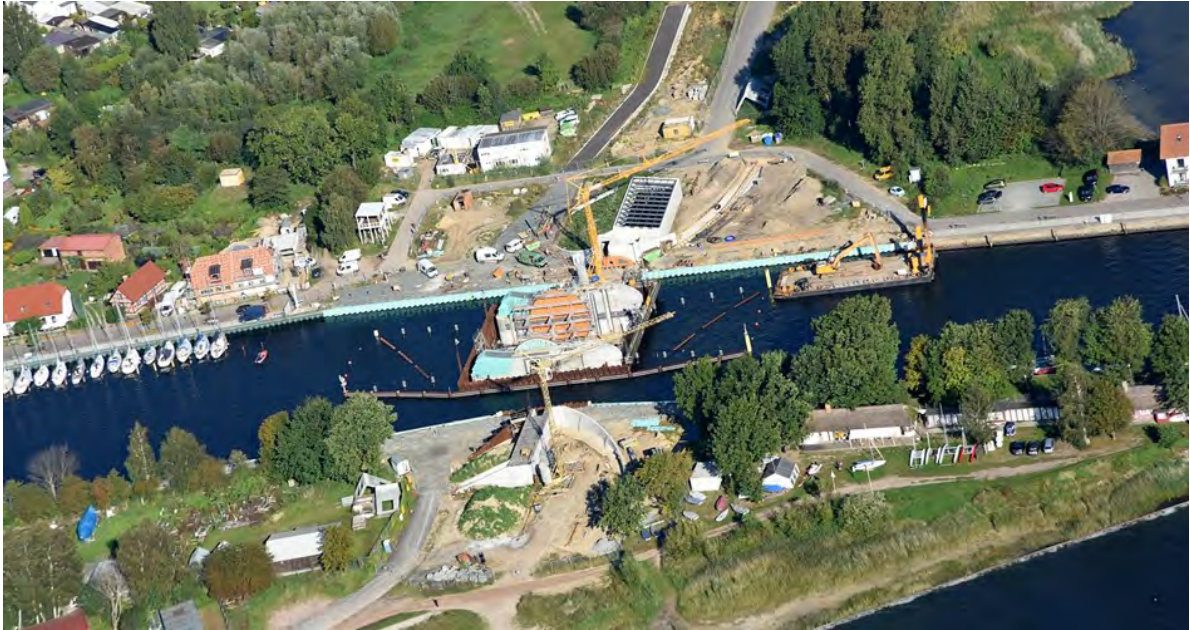
Abb. 9: Baustelle im September 2014.
