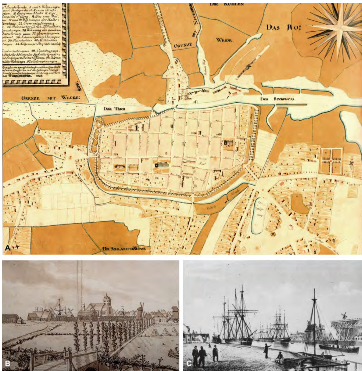
Abb. 19: Historischer Lageplan und Stadtansichten Greifswalds. A Karte mit Salzquellen nördlich des Ryck von Carl Wilhelm Woerishoffer (1826), B Gradierwerke und Windräder zum Antrieb der Solepumpen, Ansicht aus Richtung Stralsund (Carl Wilhelm Woerishoffer 1824), C Blick über den Stadthafen zu den Gradierwerken am Nordufer des Ryck (Robert Geißler 1869, Lithographie: Greifswald, Hafen mit Saline).
